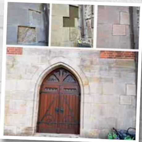
Die Sandsteinsanierung beim Glockenturm wurde abgeschlossen. U.a. wurden zwei Sandsteine ausgetauscht, die freundlicherweise von der Firma Junge aus Neukamperfehn gestiftet wurden.
